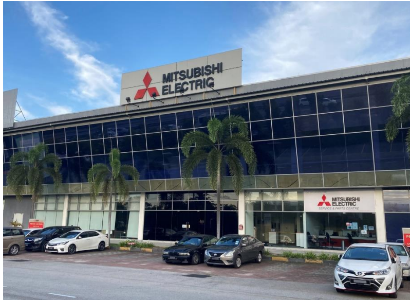
Mitsubishi Electric Sales Malaysia Sdn. Bhd، مقر مركز الخدمة المختص بمنتجات الأتمتة الصناعية الماليزي
