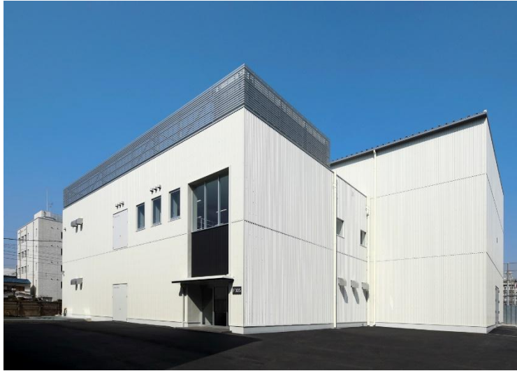
المنشأة الجديدة من شركة Mitsubishi Electric لفحص HVDC
